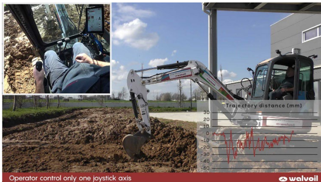
Esempio di attività del mini-escavatore con funzione assistita
